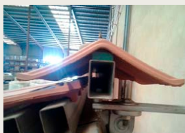
Instalación de Q90 con Teja Planum (TI)
