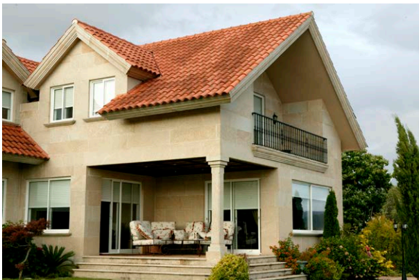
Problemas de humedades debido a una mala ventilación
