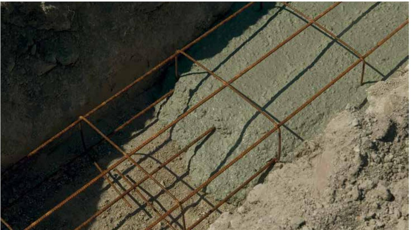
nar a través de las armaduras, sin que se produzca segregación ni bloqueo. Agilia™ Cimentaciones mantiene sus propiedades autocompactantes en camión hormigonera durante 2 horas después de su fabricación.
