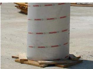
Examinar que las bocas de los encofrados estén bien cerradas por el precinto que las protege, para evitar que se introduzca la lechada del hormigón.
