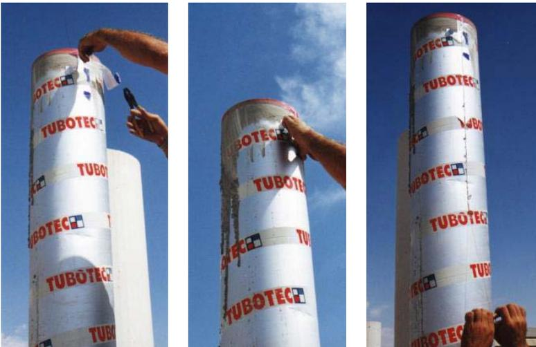
Desencofrado muy sencillo, los encofrados están dotados del sistema MF, basta con tirar del cable acerado.
