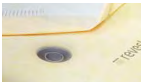
4. Extender la lámina sobre el cemento cola.
