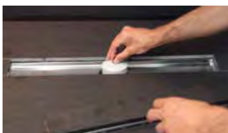
2. Colocar el cierre hidráulico (solamente en el caso de que la instalación no esté conectada a un bote sinfónico central) y seguidamente la rejilla con la pieza del pavimento adherida. En la colocación del pavimento, tener en cuenta la altura de la cuna, éste deber ir por encima de la misma.
