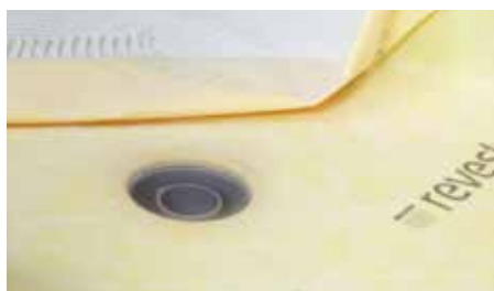
4. Extender la lámina sobre el cemento cola.
