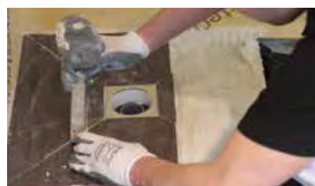
9. Proceder al alicatado de suelo y paredes.
