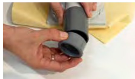
3. Si fuera necesario reducir, encolamos la reducción Ø50-40h, y la insertamos en el manguito.
