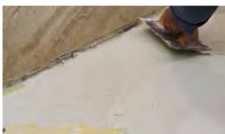
8. Extender cemento cola con la llana de 4 mm sobre la lámina.
