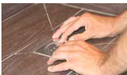
10. Colocar el cierre hidráulico (solamente en el caso de que la instalación no esté conectada a un bote sinfónico central) y seguidamente la rejilla. Ya tenemos lista la ducha perfectamente acabada y con garantía total de impermeabilización.
