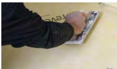
5. Comprobar que la lámina esté bien extendida y sacar el aire que se pueda haber generado con ayuda de la llana.
