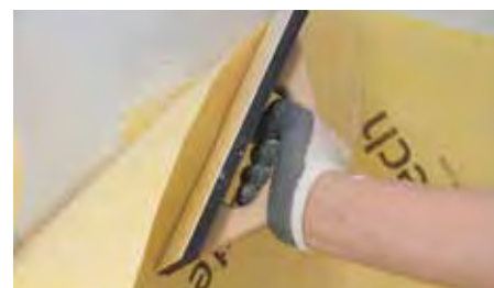
6. Revestir la pared con la lámina Revestech DRY50 dejando un solape entre láminas de al menos 5 cm.
