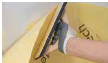
6. Revestir la pared con la lámina Revestech DRY50 dejando un solape entre láminas de al menos 5 cm.
