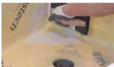
7. Formar las esquinas plegando la lámina. Para una acabado perfecto utilizar las piezas premoldeadas Cornerin y Cornerout.
