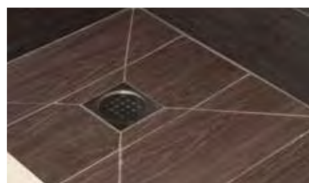
10. Colocar el cierre hidráulico (solamente en el caso de que la instalación no esté conectada a un bote sinfónico central) y seguidamente la rejilla. Ya tenemos lista la ducha perfectamente acabada y con garantía total de impermeabilización.
