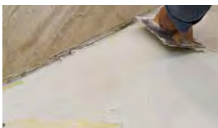
8. Extender cemento cola con la llana de 4 mm sobre la lámina y colocar la cuna del lineal sobre el sumidero.
