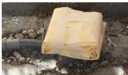
1. Conectar el sumidero a la tubería.
