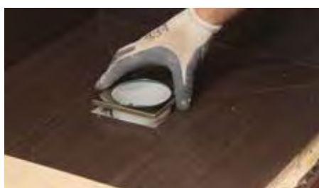
10. Colocar el cierre hidráulico (solamente en el caso de que la instalación no esté conectada a un bote sinfónico central) y seguidamente la rejilla. Ya tenemos lista la ducha perfectamente acabada y con garantía total de impermeabilización.
