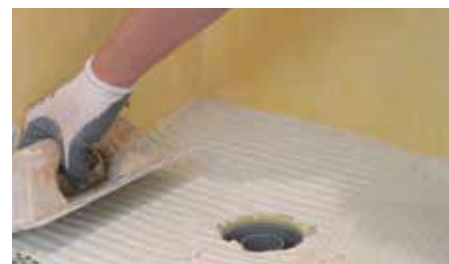
3. Extender una capa fina de cemento cola con la llana de 4 mm.
