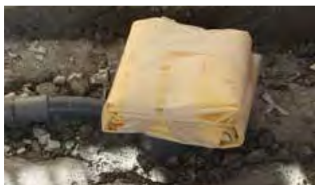
1. Conectar el sumidero a la tubería.
