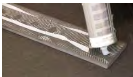
1. Unir la tira del revestimiento sobre la rejilla. Utilizar un adhesivo adecuado para ello.
