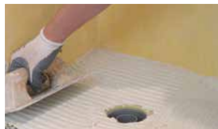
3. Extender una capa fina de cemento cola con la llana de 4 mm.
