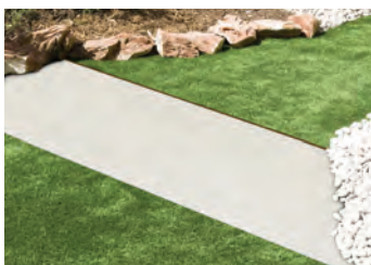
> INSTALACIÓN DE CÉSPED
