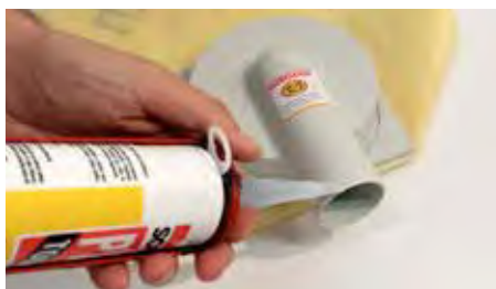
1. Poner adhesivo polímero MS en la salida del Sumi FLAT.
