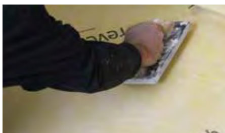
5. Comprobar que la lámina esté bien extendida y sacar el aire que se pueda haber generado con ayuda de la llana.
