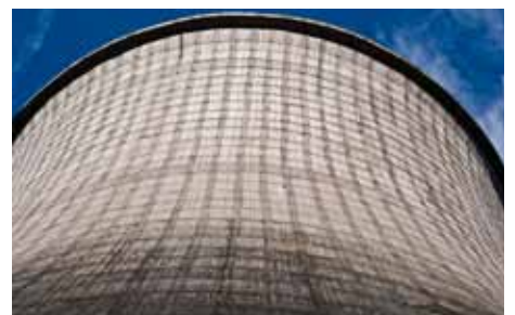
Torres de Refrigeración, Beringen (Bélgica).
