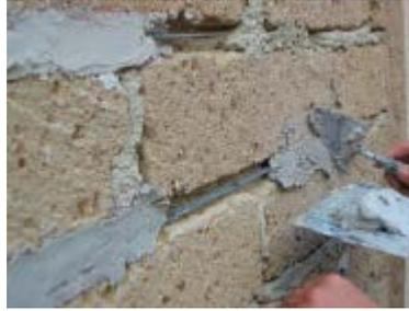
Junta armada realizada con barra en fibra de carbono y mortero de cal
