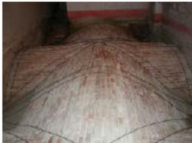
Armazón con barras en fibra de carbono antes de la aplicación del mortero de cal
