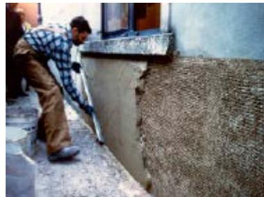
Deshumidificación del muro sujeto a humedad ascendente mediante enlucido macroporoso
