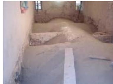
Capa armada realizada con mortero de cal y barra en fibra de carbono
