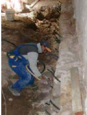
Inyección de consolidación de la cimentación con mortero de cal
