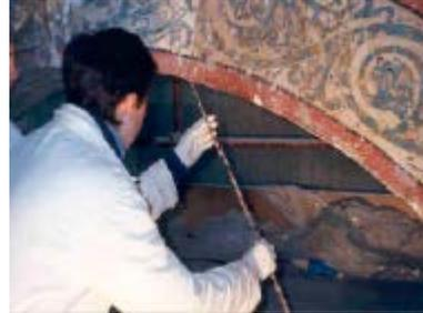
Inyección armada con barras en FRP y resina epoxídica
