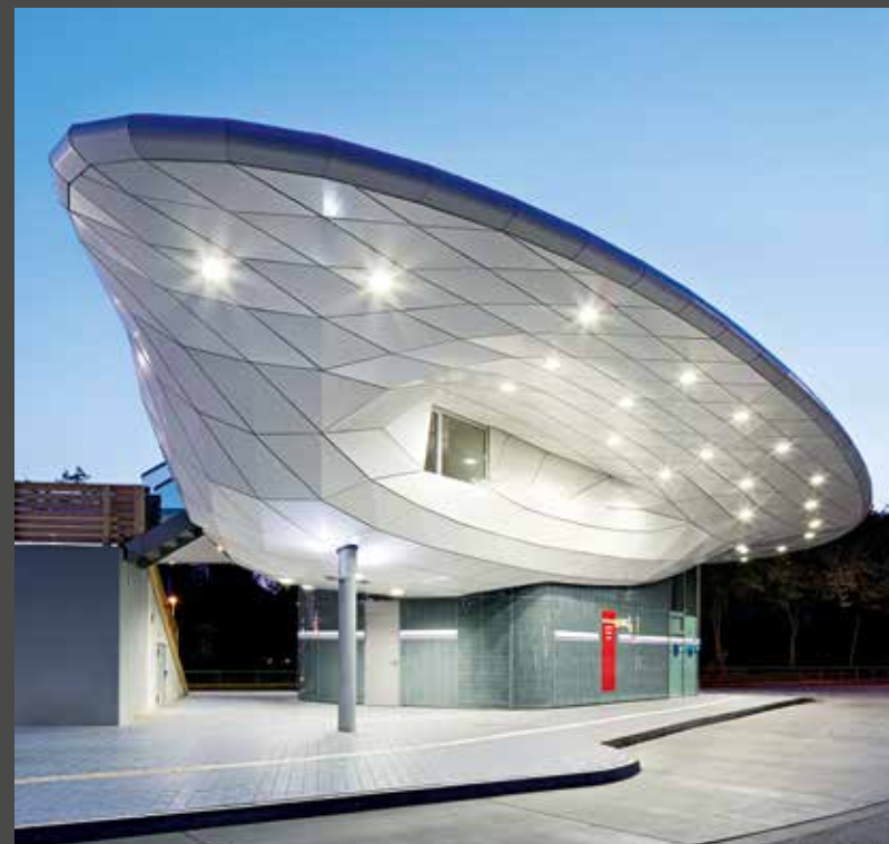
El techo suspendido en forma de ala de ALUCOBOND® blanco puro de la estación de autobuses de Hamburgo Poppenbüttel. | Foto: archimages
