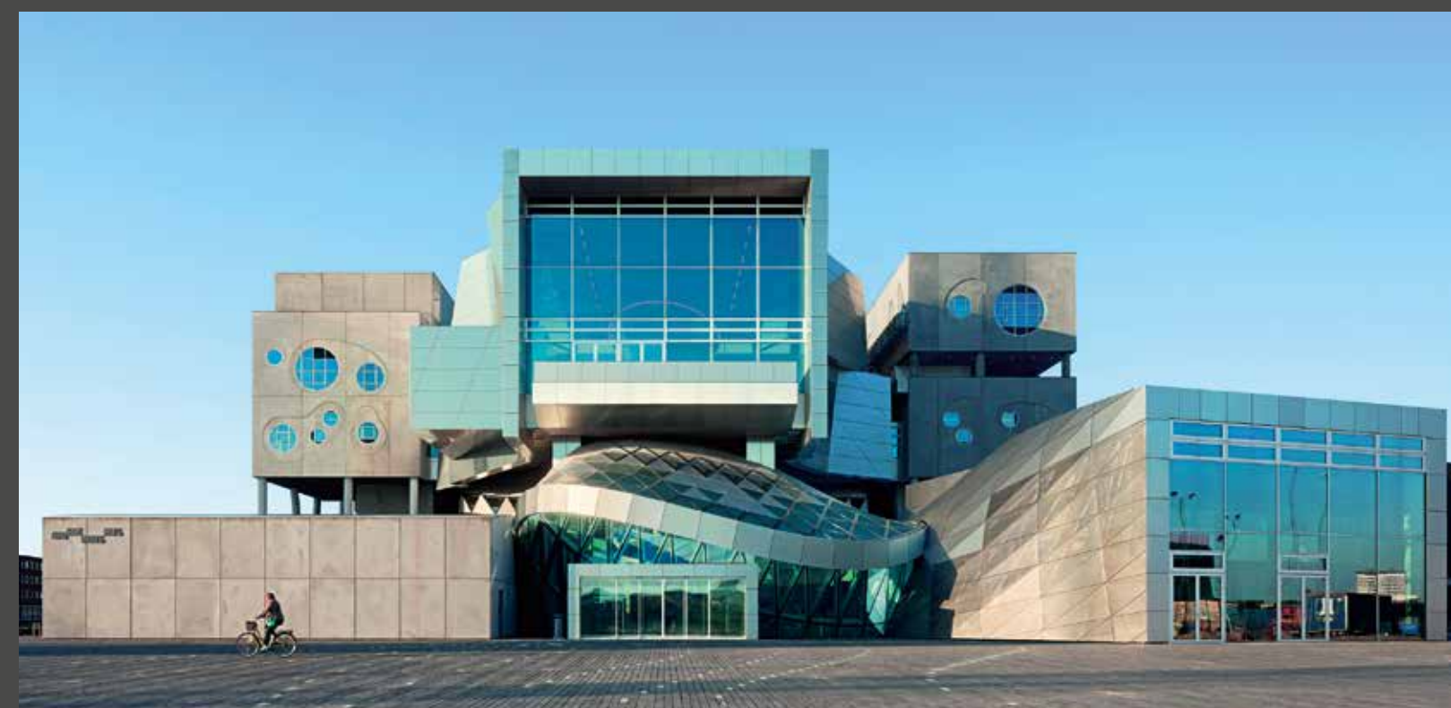
La fachada de paneles composite de aluminio ALUCOBOND® en naturAL Brushed confiere al edificio un carácter individual. | Fotos: Duccio Malagamba
